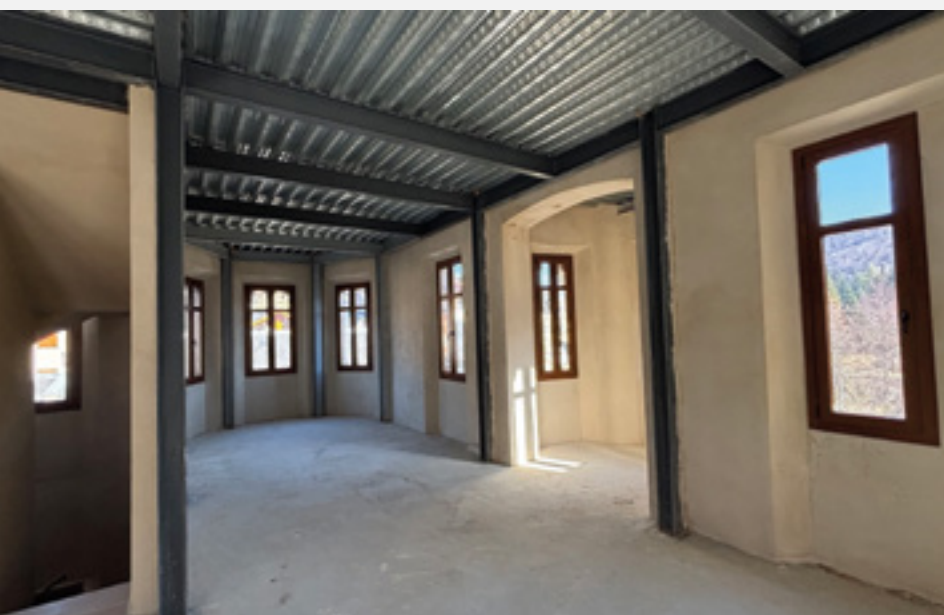
Forjat col·laborant a la planta pis, amb jàsseres i pilars metàl·lics.
