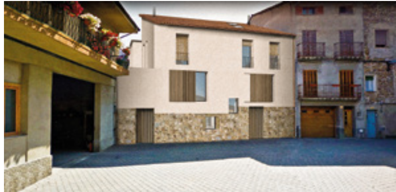
Rectoria de Montagut. Façana principal.
