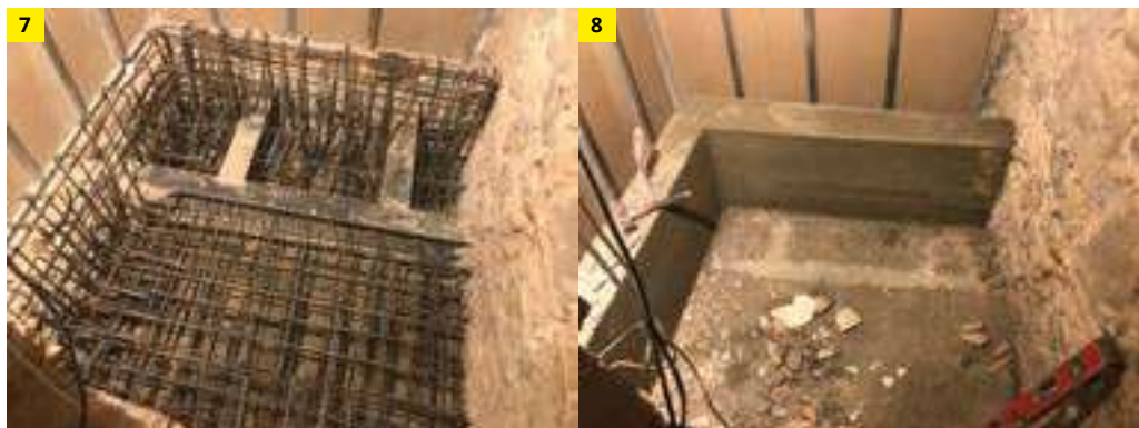
7. Armat llosa del fossat. 8. Fossat reduït acabat.
