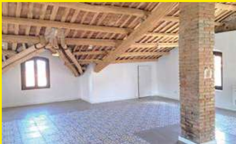
La sala Noble de l'ajuntament, un cop acabades les obres de restauració. Les golfes de l'edifici, un cop acabades les obres de restauració. Fotografies: Ajuntament de Viladrau, març 2024.
