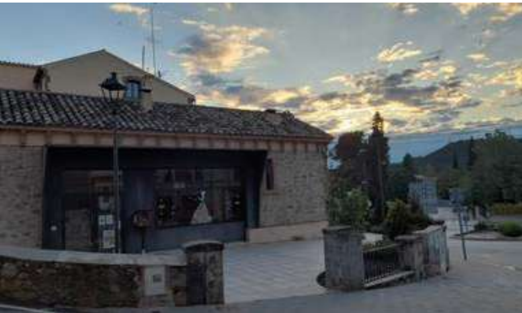
Ala est de l'edifici després de les obres pel Centre de Gent Gran. Fotografia Oscar Farrerons, maig 2024.
