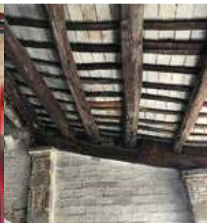
Tipus de forjats presents a l'edifici
