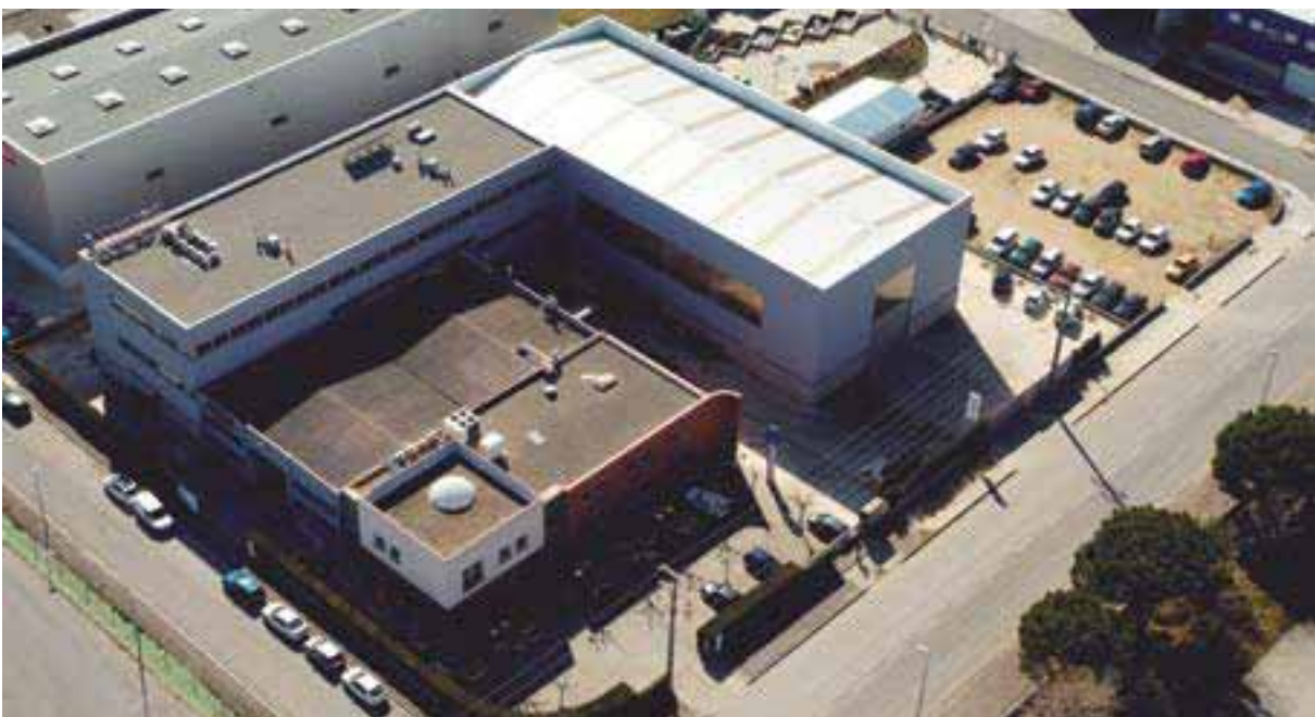
Vista aèria de les instal·lacions de Celrà
