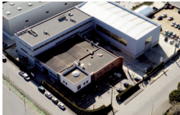
Vista aèria de les instal·lacions de Celrà
