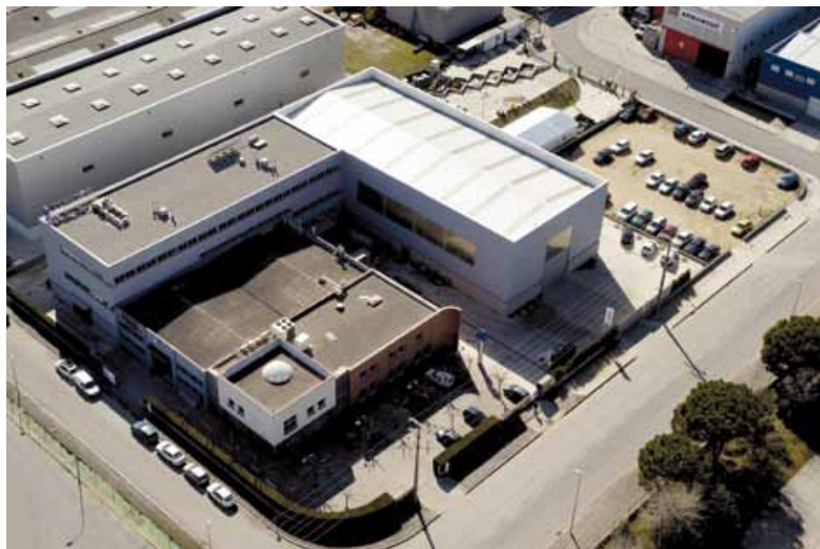
Vista aèria de les instal·lacions de Celrà.
