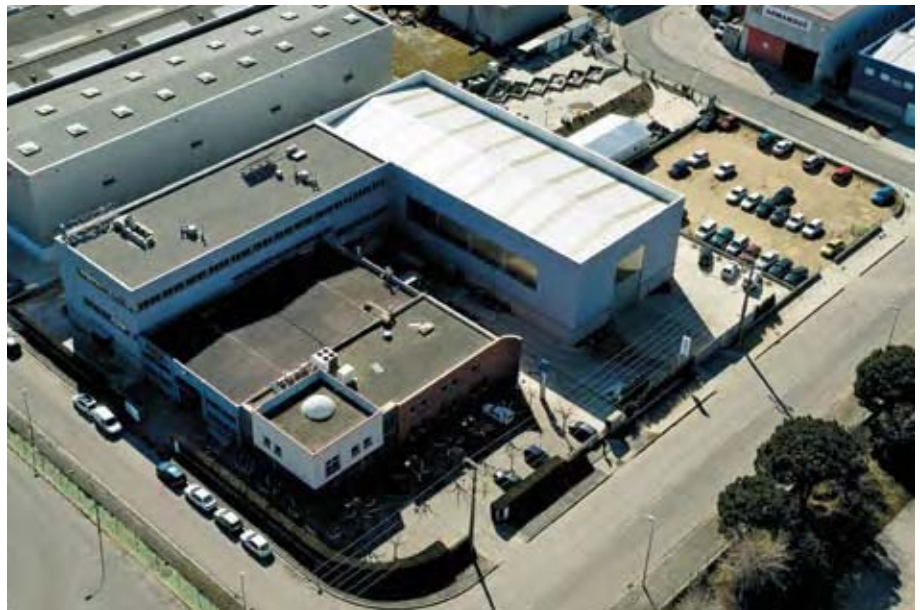
Vista aèria de les instal·lacions de Celrà
