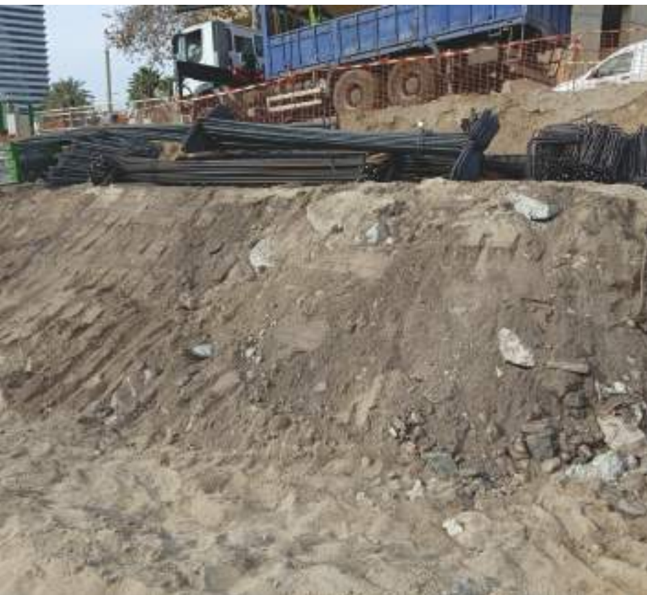
Terres d'obra excavades.
