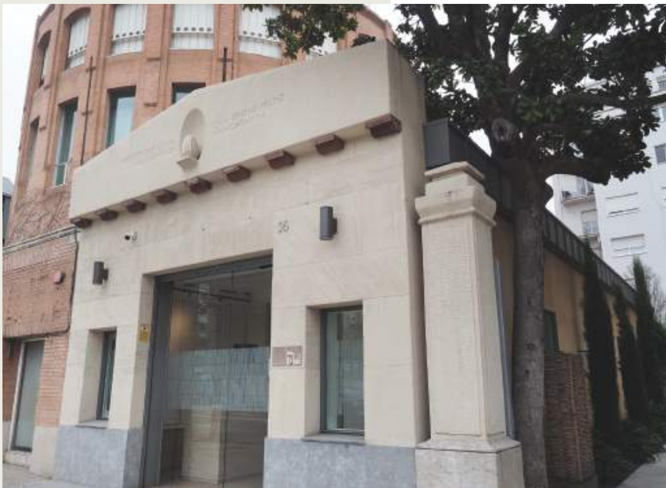
Vista de l'edifici annex rehabilitat. Fotografia: Pere Duran.
