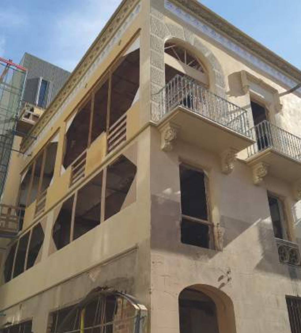
Imatge del procés de rehabilitació de la façana. Fotografia: David Giró.
