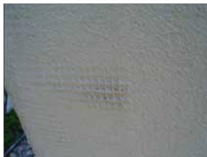
Cubrición insuficiente de la malla de refuerzo.
